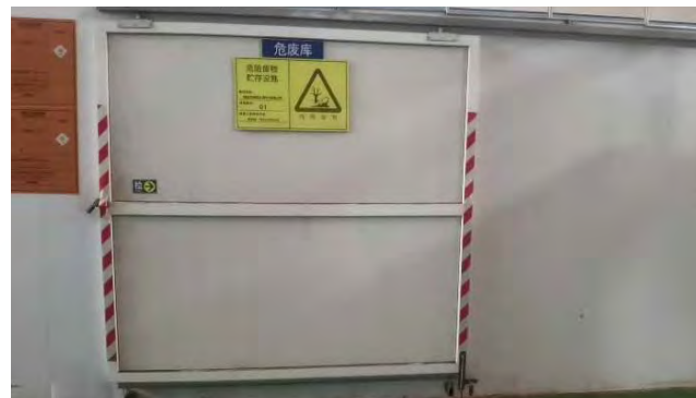
有害廢棄物儲存區及入口危害標示
